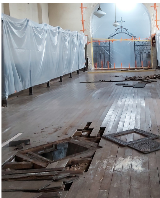
La dépose des grilles des calorifères avant la démolition du parquet.
