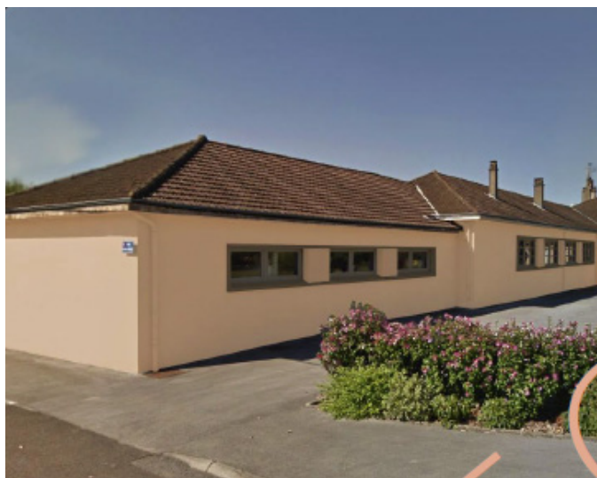
Vue de l'école après travaux
