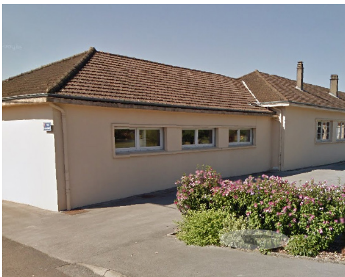
Vue de l'école avant travaux
