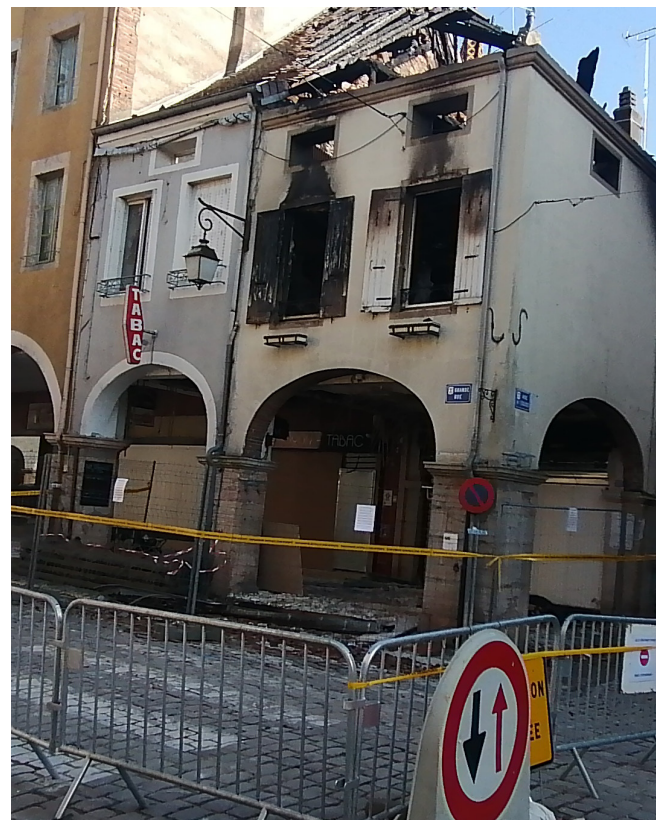
Un périmètre de sécurité interdit toute circulation de véhicules ou piétons aux abords des bâtiments sinistrés.
